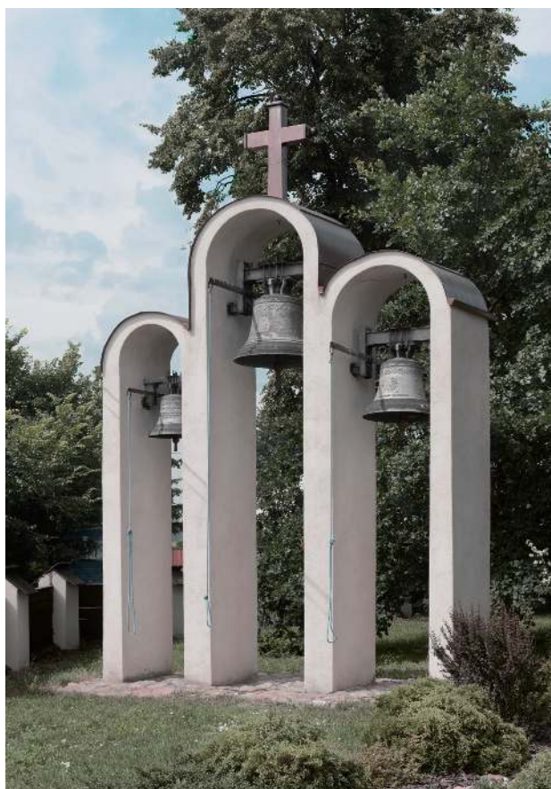
■ Dzwonnica murowana ■ Brick belfry
